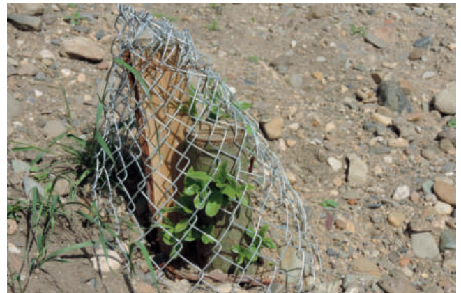
Foto 33: Zum Schutz vor dem Biber können auch Setzstangen und andere ingenieurbioologische Bauweisen mit Drahtgeflecht umhüllt werden. (Foto: A. Stowasser)
