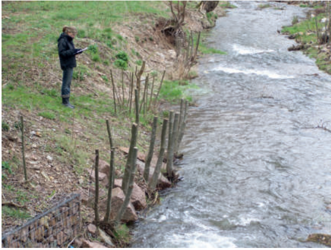
Foto 29: falscher Rückschnitt von Gehölzjungpflanzen einer begrünten Steinschüttung (Foto: A. Stowasser).
