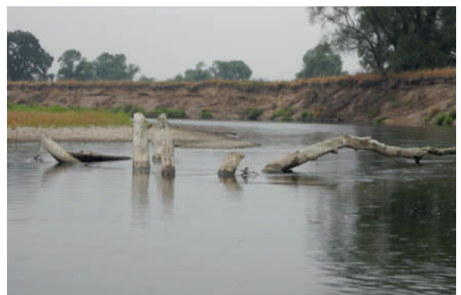
Foto 64: Gefährdung durch herausragende und unter der Wasseroberfläche befindliche Totholzteile (Foto: A. Stowasser)
