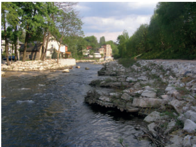
Foto 19: Ufersicherung und Strukturverbesserung durch verschiedene ingenieurbioologische Bauweisen und eine aufgelöste Uferlinie (Foto: A. Stowasser)
