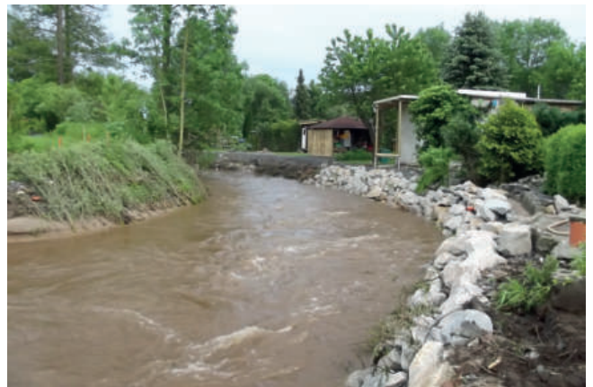
Foto 16: Hochwasserabfluss kurz nach Baufertigstellung ohne Auswirkungen auf die Bauweise (Foto: A. Stowasser)
