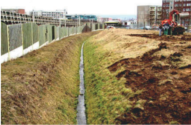
Foto 11: geradliniger und gehölzfreier Verlauf des Weidigtbachs vor der naturnahen Umgestaltung (Foto: A. Stowasser)
