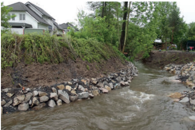
Foto 15: Begrünung des Gewässers durch verschiedene ingenieurbio- logische Bauweisen (Foto: A. Stowasser)
