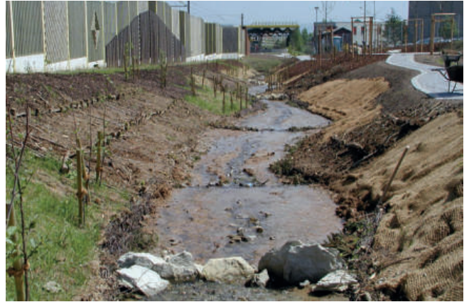
Foto 12: Begrünung des Gewässers durch verschiedene ingenieurbio- logische Bauweisen (Foto: A. Stowasser)
