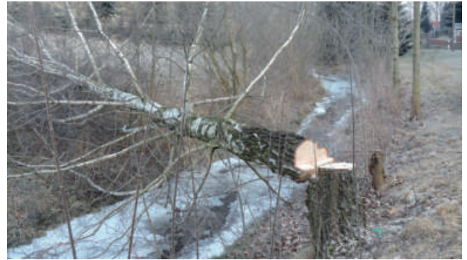
Foto 78: Die Gehölzentnahmen sind unter Schonung des Bestandes durchzuführen. (Foto: A. Stowasser)
