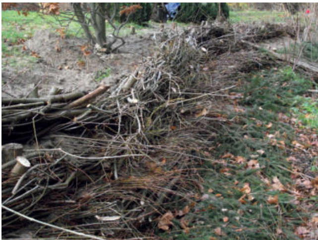
Foto 5: Weidenwippen bieten einen intensiven Schutz für Böschungsfuß und Böschung. (Foto: A. Stowasser)
