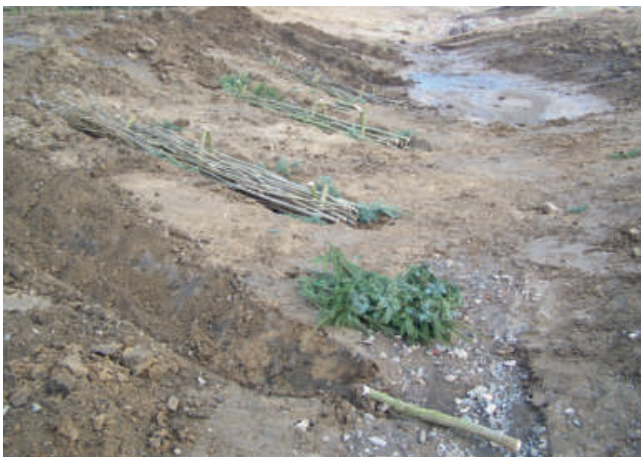
Foto 3: Zur Strömunglenkung werden Lebendfaschinen diagonal auf der Uferböschung eingebaut. (Foto: A. Stowasser)
