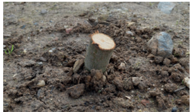
Foto 8: Auffaserungen beim Einbau vermeiden bzw. durch glatten Nachschnitt beseitigen. (Foto: A. Stowasser)
