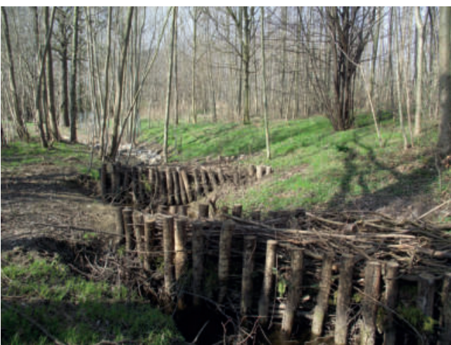
Foto 101: Soll Totholz vor Ort oder an anderer Stelle fixiert werden, sind Totholzbahnen eine Möglichkeit der Fixierung des Materials. (Foto: A. Stowasser)
