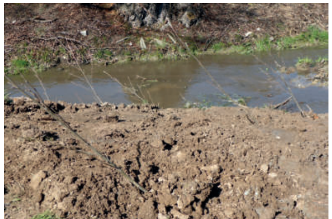
Foto 18: Die Gehölze werden in Reihen angeordnet gepflanzt. Die Neigung der Pflanzen in Fließrichtung verhindert Überflutungsschäden kurz nach der Pflanzung. (Foto: A. Stowasser)
