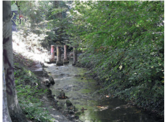
Foto 115: Diese Holzpfähle sind im Bereich des Mittelwassers mit einer Stahlplatte als Anprallschutz versehen. Dennoch müssen Holzpfähle regelmäßig kontrolliert und bei beginnender Vermorschung ersetzt werden. (Foto: M. Dittrich)
