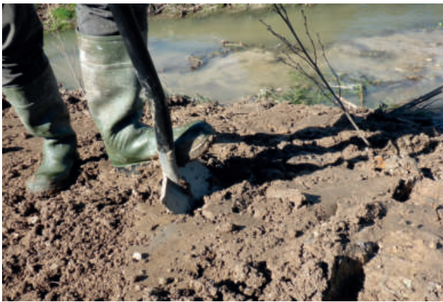
Foto 15: Je nach Gegebenheit Pflanzflächen durch Mahd und Entsorgung des Mähgutes vorbereiten. Auftrag von Oberboden ist nicht erforderlich – die Pflanzung kann direkt in den Rohboden erfolgen. (Foto: A. Stowasser)
