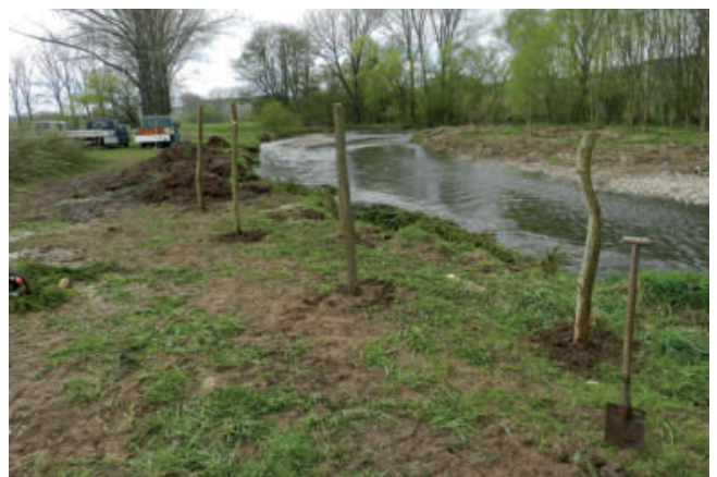
Foto 12: Alternativ zum nachträglichen Zuschlämmen der Bohrlöcher können diese auch vor dem Einbau der Setzstangen mit einem Brei aus Oberboden, Feinmaterial und Wasser verfüllt werden, in den dann die Setzstangen eingedrückt werden. (Foto: A. Stowasser)
