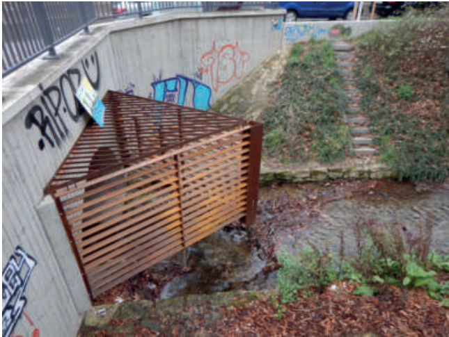
Foto 109: Die Art der Bauausführung orientiert sich an der Art des zu erwartenden Materials und den örtlichen Gegebenheiten. (Foto: M. Dittrich)
