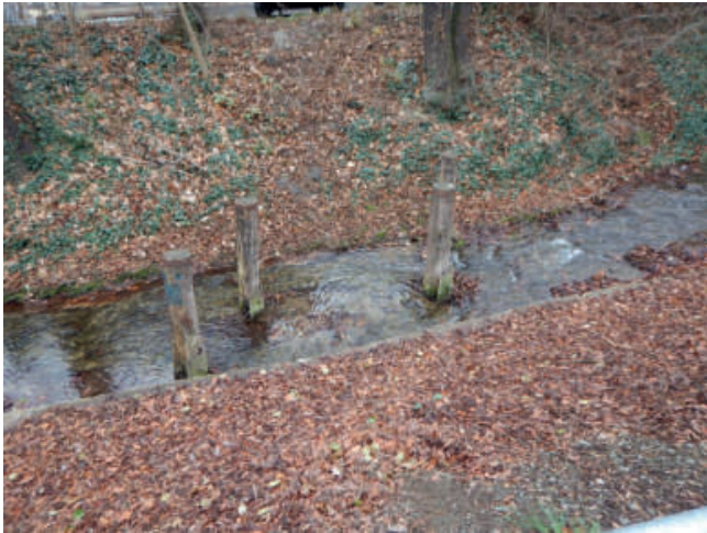
Foto 114: Treibholzsperrre an einem kleinen Gewässer, die Größe ist in Abhängigkeit vom erwarteten Schwemmgut und dem höchstmöglichen Aufstau beim Bemessungsabfluss zu wählen. (Foto: M. Dittrich)
