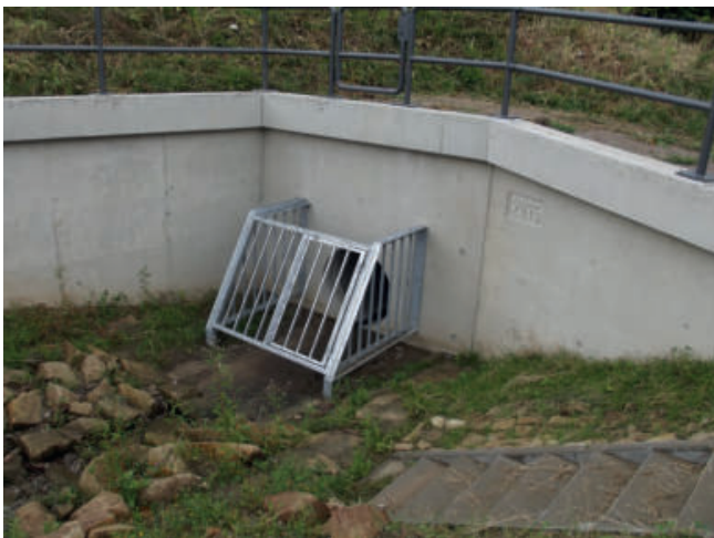
Foto 111: Treibgutrechen an einem Durchlassbauwerk, im Bereich des Mittelwassers ist die Durchgängigkeit für kleines Material und ein Schlupf zu ermöglichen. (Foto: A. Stowasser)
