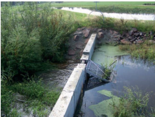
Foto 113: An Stillgewässern und Rückhaltebecken sammeln Treibgutrechen vorwiegend krautiges pflanzliches Material. (Foto: A. Stowasser)
