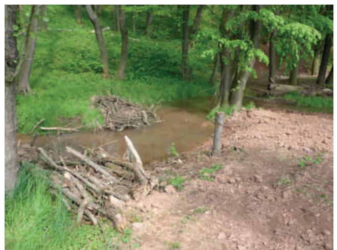
Foto 102: Je nach Art des Einbaus und der Fixierung des Totholzes am Ufer kann eine Strömungslenkung und Strömungsdifferenzierung erreicht werden. (Foto: A. Stowasser)
