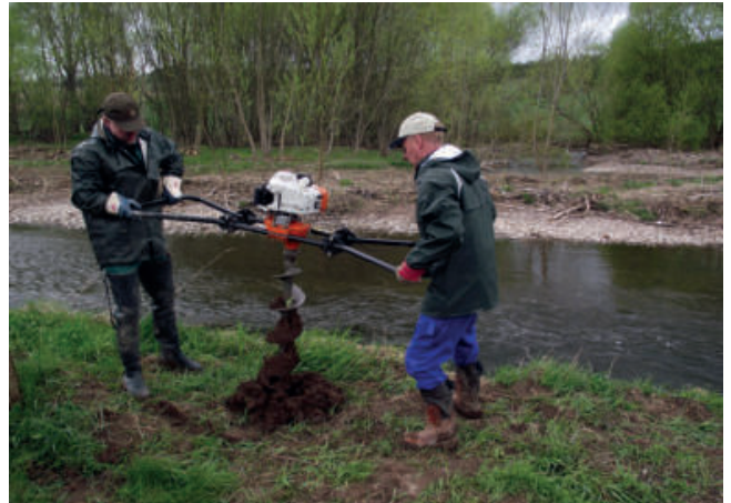
Foto 11: Herstellung des Pflanzlochs mit dem Pflanzbohrer (Foto: A. Stowasser)
