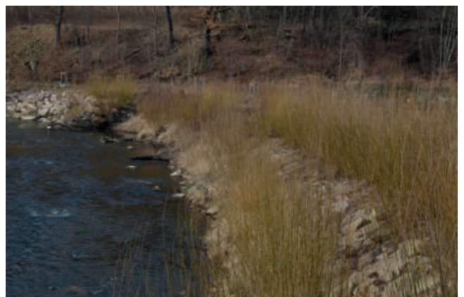
Foto 60: Der aus den ingenieurbiologischen Bauweisen entwickelte Ufergehölzbestand ist aufgrund des regelmäßigen Auf-den-Stock-setzens auch sieben Jahre nach Bau fertigstellung weiterhin strauchförmig und niedrig. (Foto: A. Stowasser)
