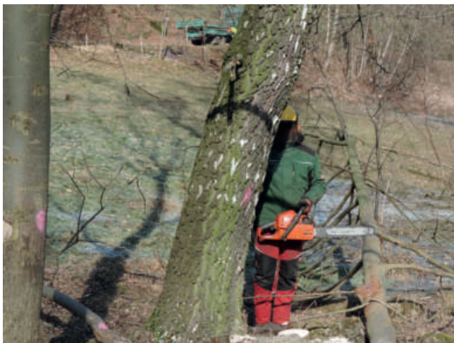
Foto 79: Unter Beurteilung der örtlichen Gegebenheiten und der Wuchsrichtung des Baumes wird die Fällrichtung festgelegt. (Foto: A. Stowasser)
