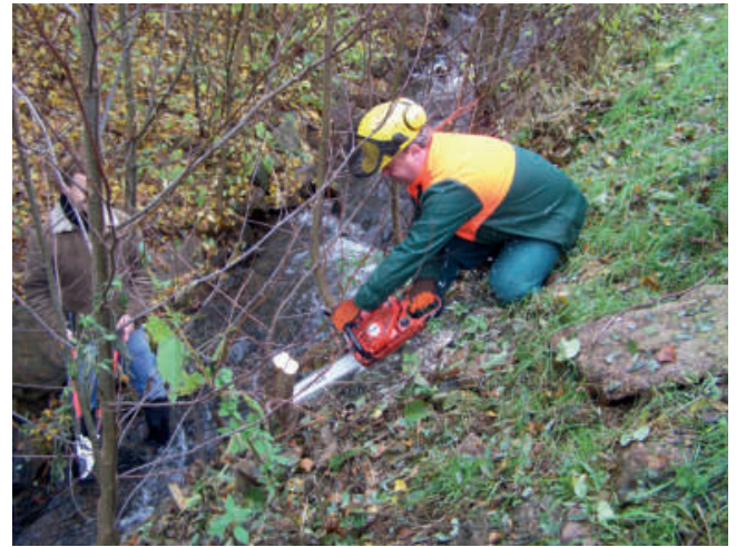
Foto 48: Der übrige Aufwuchs sowie standortfremde Arten werden möglichst tief über dem Erdboden mit schrägem, glatten Schnitt parallel zur Uferböschung zurückgeschnitten. (Foto: A. Stowasser)
