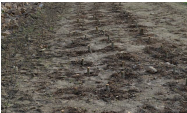
Foto 7: Stekhölzer max. 5 cm über der Böschungsoberfläche glatt absägen. (Foto: A. Stowasser)
