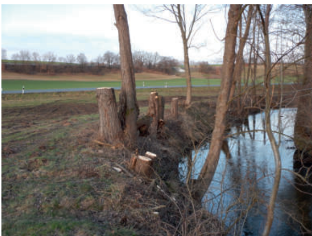
Foto 74: Unsachgemäße Saumpfleger / Gehölzfällung: Gehölze auf der Uferböschung sind zu belassen. Falls ein Rückschnitt erforderlich wird, soll dieser möglichst tief ansetzen. (vgl. Foto 63, Foto: M. Dittrich)
