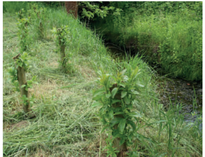
Foto 29: Durch Mahd der Grasflächen erhalten die Setzstangen mehr Licht und wachsen besser. (Foto: A. Stowasser)
