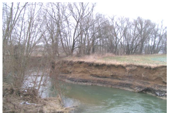
Abb. 10 Stark tiefenerodiertes Gewässer [Foto: M. Ditttrich]
