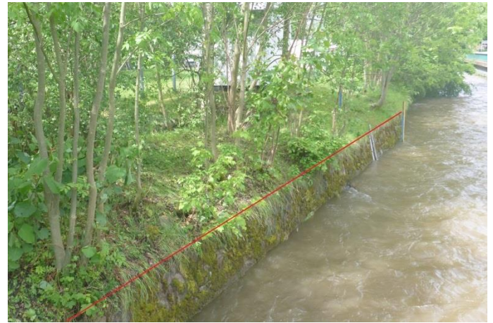
Abb. 9 Ausgebautes Gewässer mit senkrechter Ufermauer als künstliche Böschungsoberkante [Foto: THLG]
