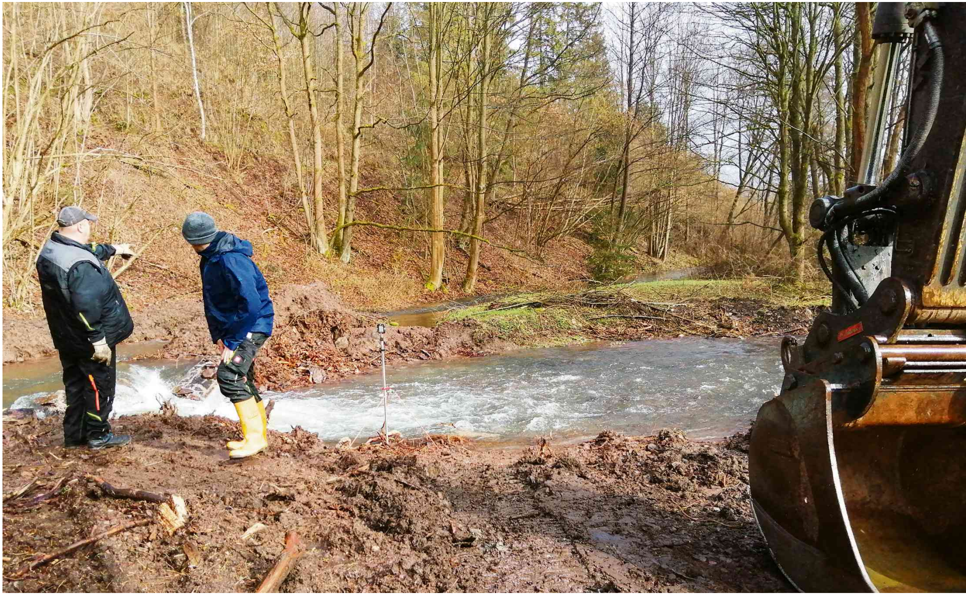
Vermesser David Stagge (rechts) und Baggerfahrer Steffen Becker hatten Anfang der Woche ihre Arbeitsplätze in den Bereich der Schorte verlegt.
